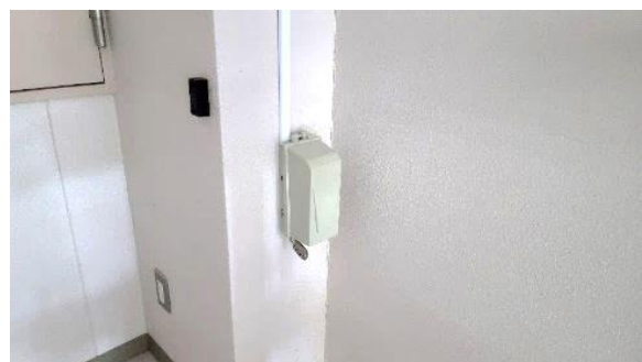
図 23. 増設 LAN ポートの形状
